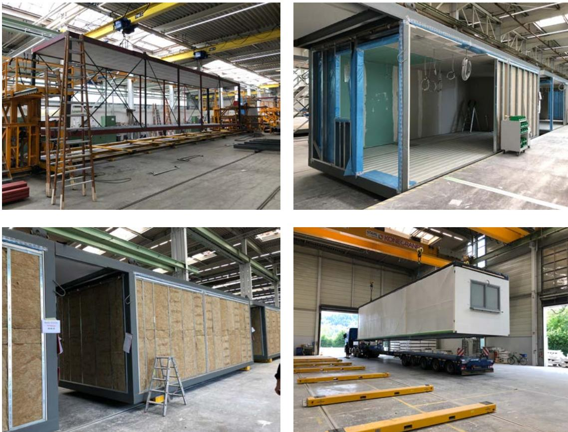
Abb. 6: ALHO: Produktionsschritte Rohbau, Innenausbau, Fassade; Abtransport eines Fertigen Moduls (Fotos: eigene Aufnahmen)
