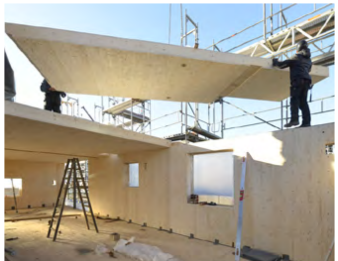
Abbildung 21: Woodcube Deckenverlegung
