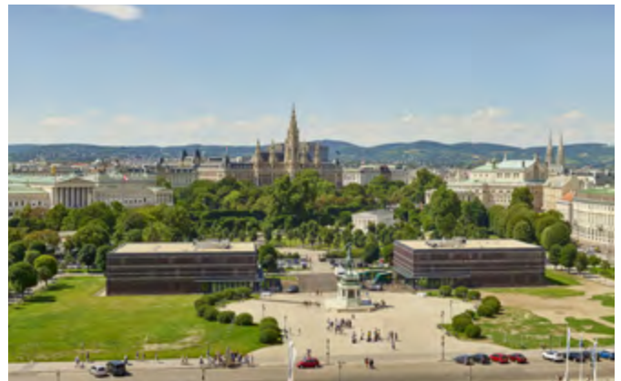
Abbildung 10: Lukas Lang Building Technologies GmbH; Temporäres Parlament, Wien, Bauherr Parlamentgebäudesanierungsgesellschaft m.b.H., Auftraggeber STRABAG AG, Baufertigstellung 21.04.2017.
