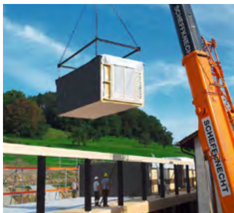
Abbildung 14: Montage der Raummodule, Kaufmann Bausysteme
