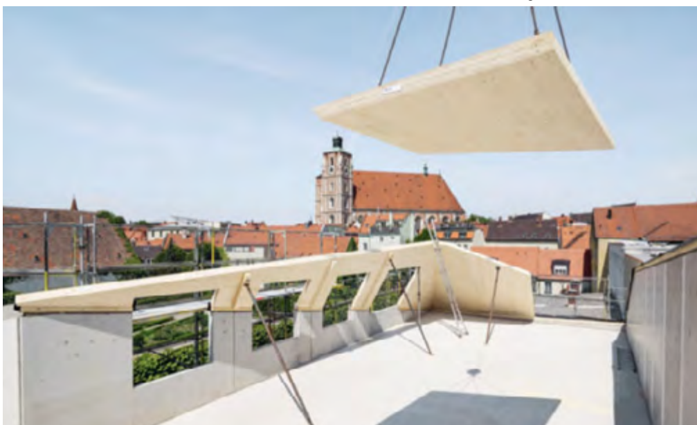
Abbildung 11: LENO-Brettsperrholz. Massive großflächige Elemente ohne Rasterbindung.
