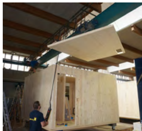
Abbildung 15: Fertigung Module Das Bader Hotel, Parsdorf, Kaufmann Bausysteme
