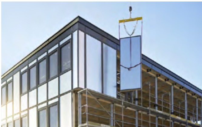
Abbildung 9: Lukas Lang Building Technologies GmbH; Montage Fassade.
