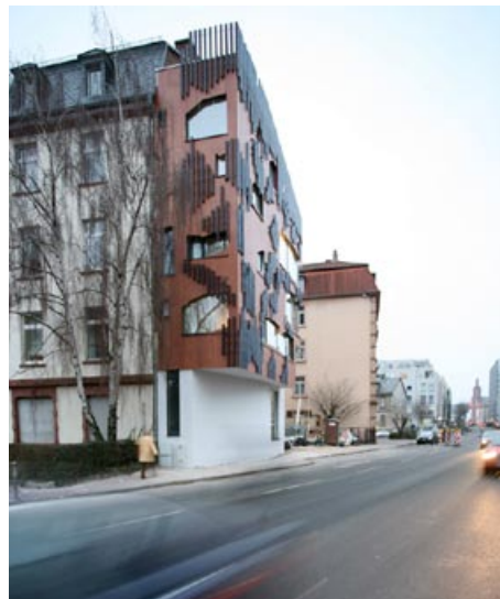
Im Erdgeschoss ist es gerade 110 Zentimeter breit
