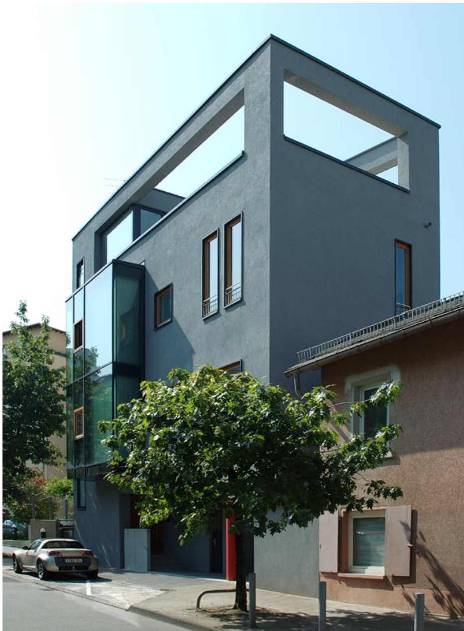
Das kleine Haus am Mittleren Hasenpfand in Sachsenhausen wird nur von der Ost- und der Nordseite belichtet.
