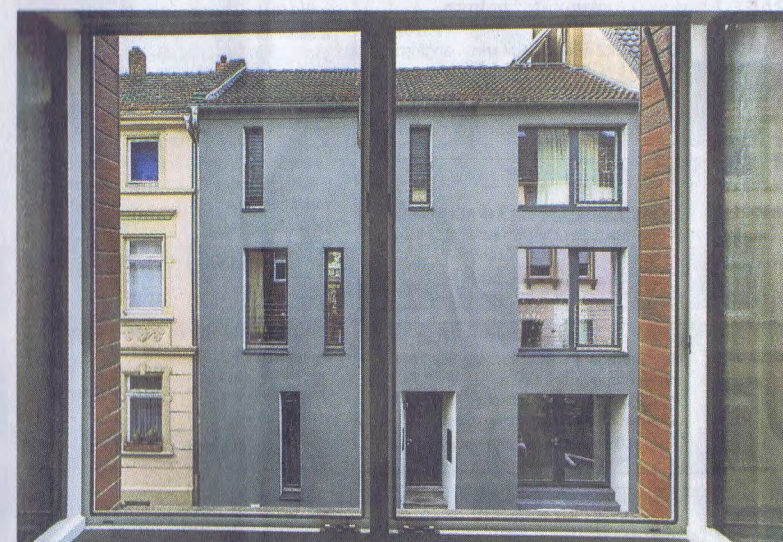
Neuer Auftritt: Mit der alten Fassade hat die neue nur wenig gemein.
