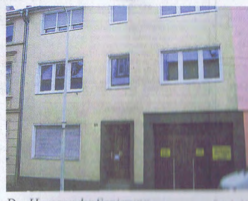
Das Haus vor der Sanierung
