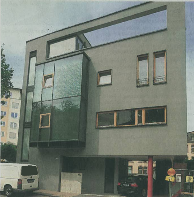
Weitblick: Glaserker und Dachterrasse schaffen Großzügigkeit.
