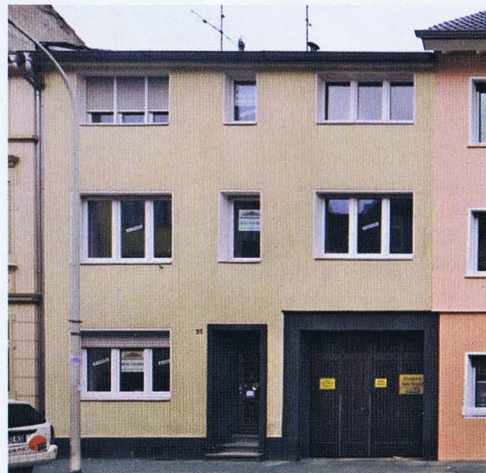
VORHER Der Nachkriegsbau von 1949 berherbergte vorn vier Parteien, im Hof und dem Hintergebäude arbeitete eine Druckerei
