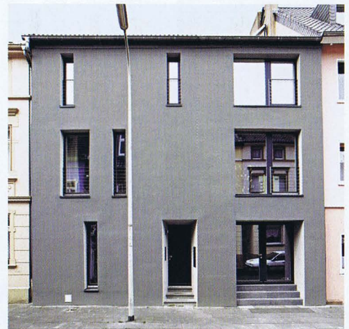
NACHHER Die neuen Formate der Fenster und deren Platzierung machen die Fassade interessant. Das Obergeschoss wurde erhöht
