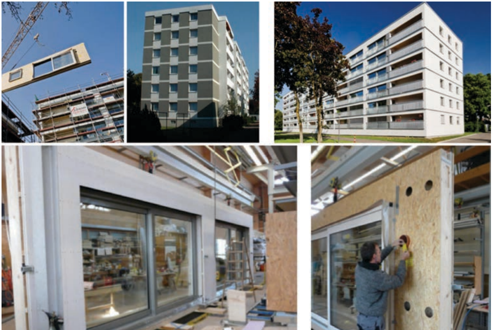
Abb.17 Bilder: Vorgefertigtes Fassaden-System zur Sanierung, Grünenstraße 30-36, Augsburg, Latzke Architekten.
