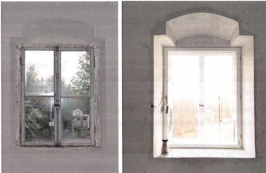
Links: Originales Fenster vor der Sanierung 2014. Rechts: Originales Fenster instandgesetzt mit Innenvorfenster, 2018.
