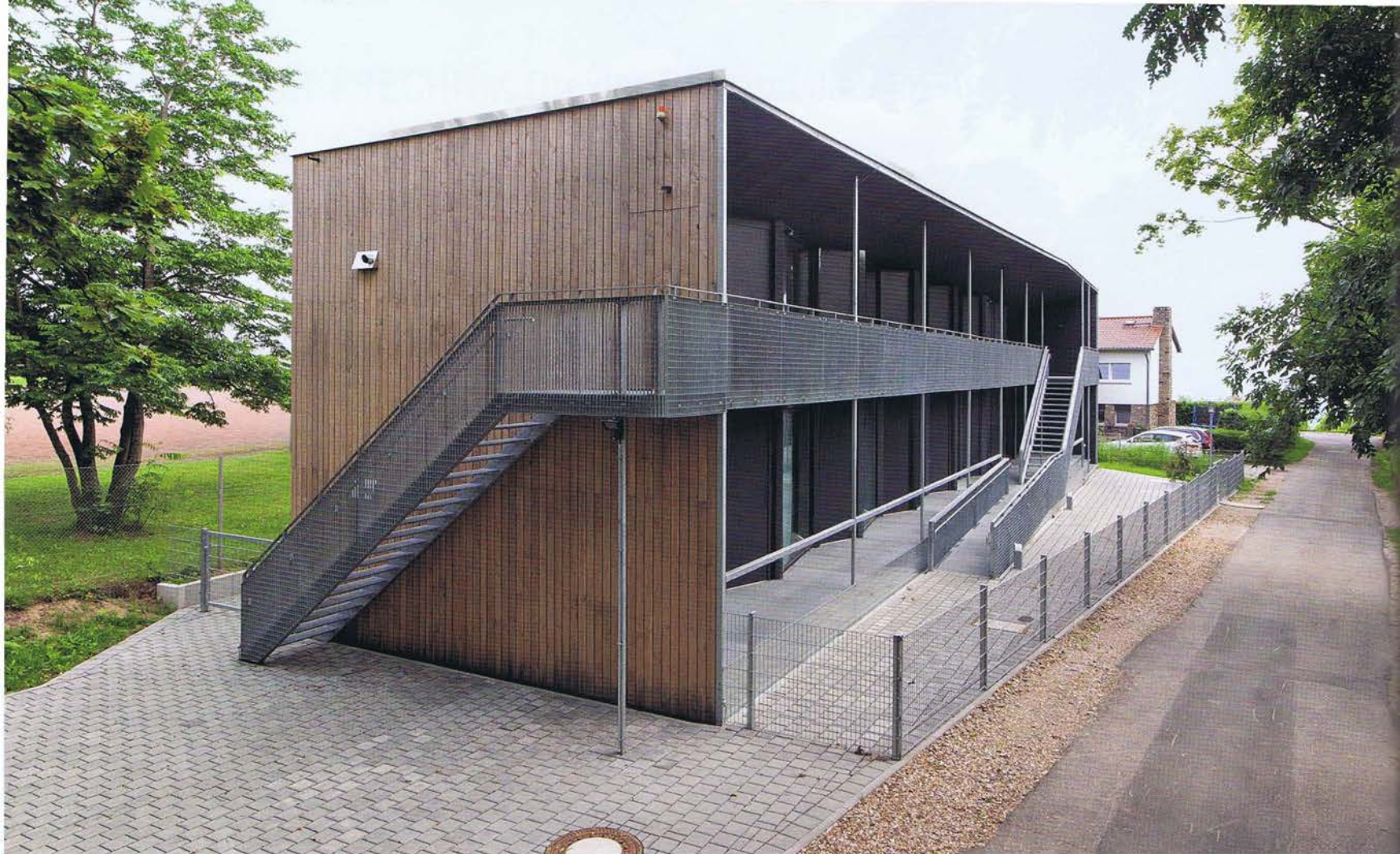
Ansicht von Nordwesten. Die Laubengängerschließung verringert die zu beheizende Fläche und reduziert die sommerlichen Wärmeeinträge.
