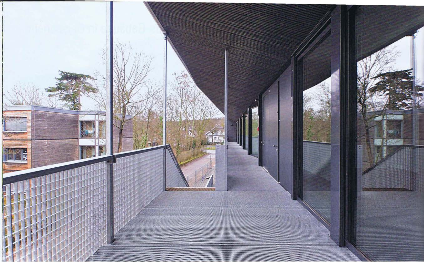
Laubengang zur unbeheizten Erschließung im Obergeschoss
