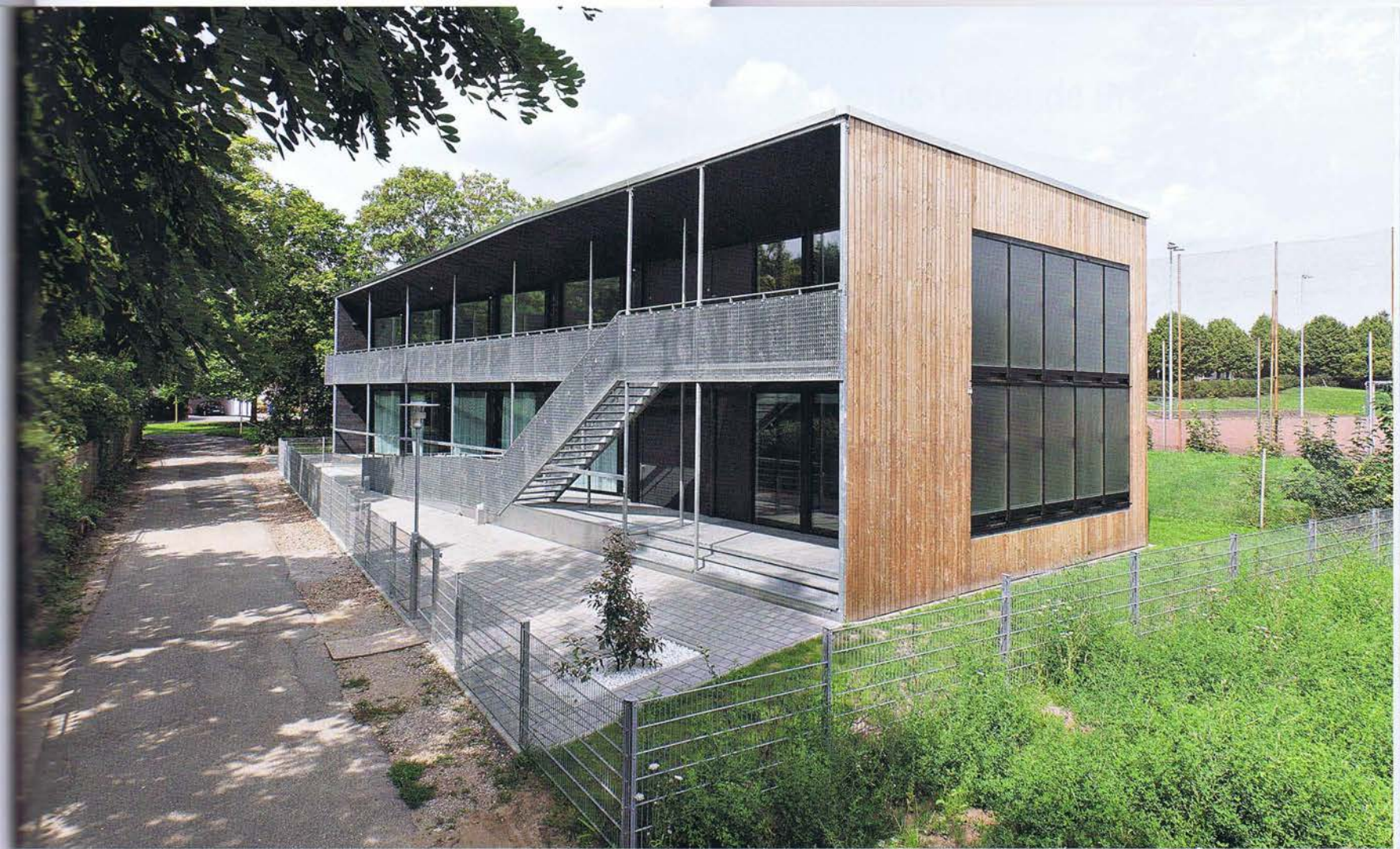
Ansicht aus Südwesten. In die Südfassade ist ein Feld mit Solarthermie-Kollektoren integriert.
