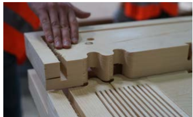
Montage Eckverbindung
