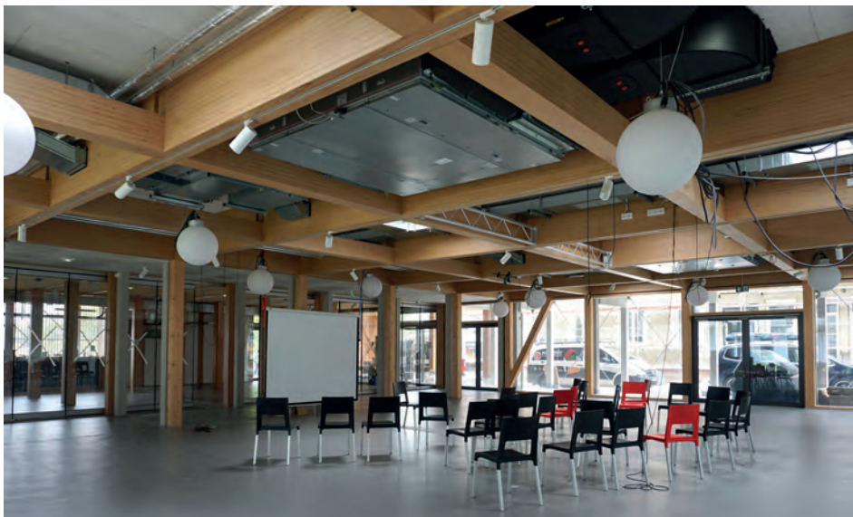
De kolommen in de aula zijn van Baubuche (LVL) en bij de vluchtweg van beton.
