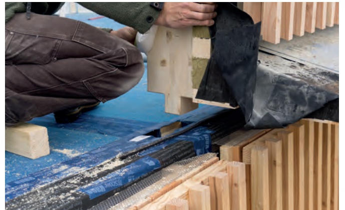
Net als gehele draagconstructie is ook de gevel zonder metalen verbindingen bevestigd.
