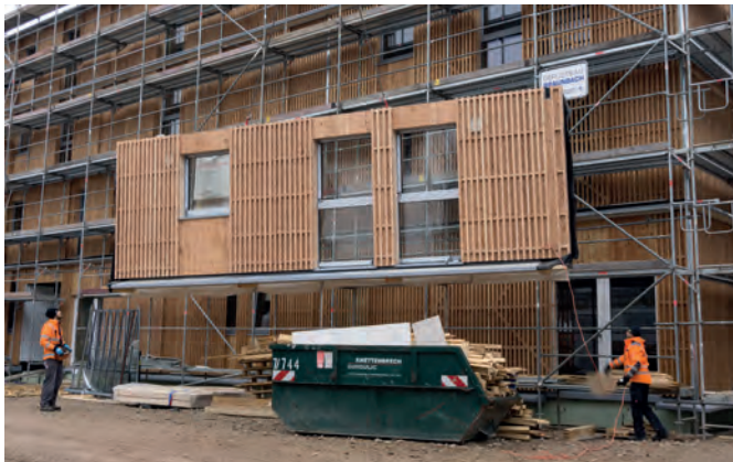
Door industriële productiemethoden, waaronder de prefabricage van de gevel-elementen, is de kostenefficiëntie verhoogd
