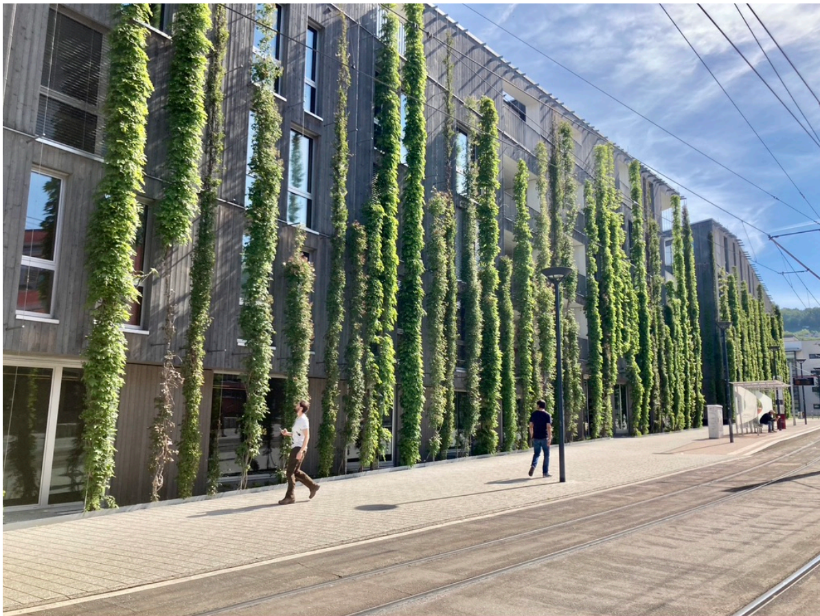
Abbildung 29 Fassadenansicht Stadthaus M1 Freiburg. [Foto: © Van Lier, Kilian, 2021]
