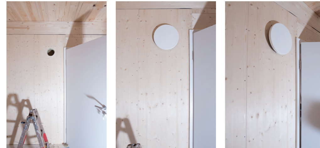
Abbildung 32: (rechts) Überströmelement mit Schalldämmung. Fotos: Carina Bauer.
