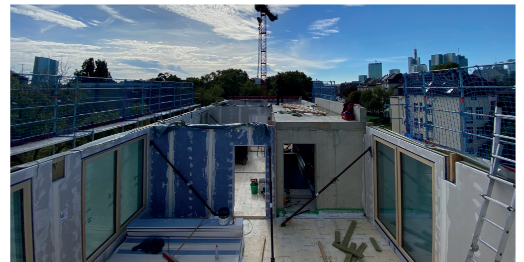
Abbildung 114: Montage der Decken, dgj228.
