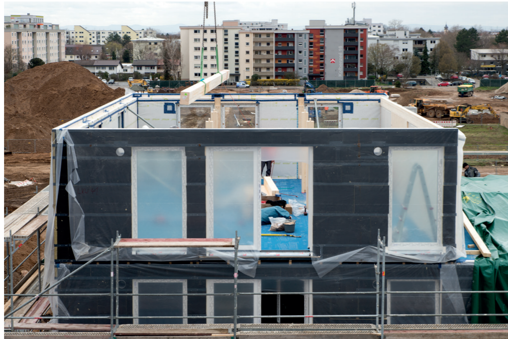
Abbildung 66: Montageprozess Unterzüge beim Modellvorhaben Fotos: DGJ Architektur,
