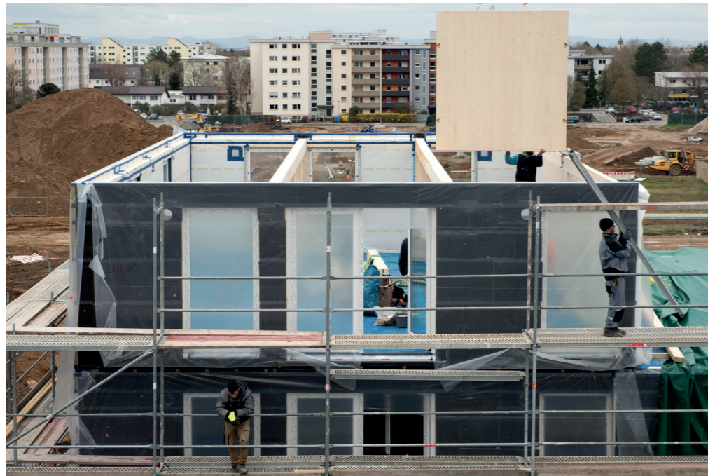
Abbildung 70: Montageprozess aussteifende Innenwände beim Modellvorhaben Fotos: DGJ Architektur.
