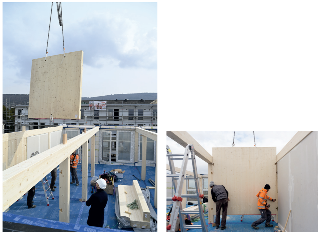
Abbildung 71: Montageprozess aussteifende Innenwände beim Modellvorhaben Fotos: DGJ Architektur.
