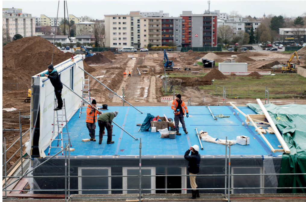
Abbildung 57: Beginn der Montage einer Außenwand. Foto: DGJ Architektur.
