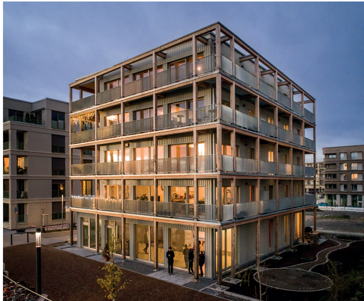
Abbildung 117: Das „WohnWerk“ stellt einen Teil des Erdgeschosses dem Quartier zur Mitnutzung zur Verfügung, beispielsweise für ein Angebot von Gesundheitskursen oder für private Feiern. Foto: Johannes Vogt, Quelle: DGJ Architektur GmbH.
