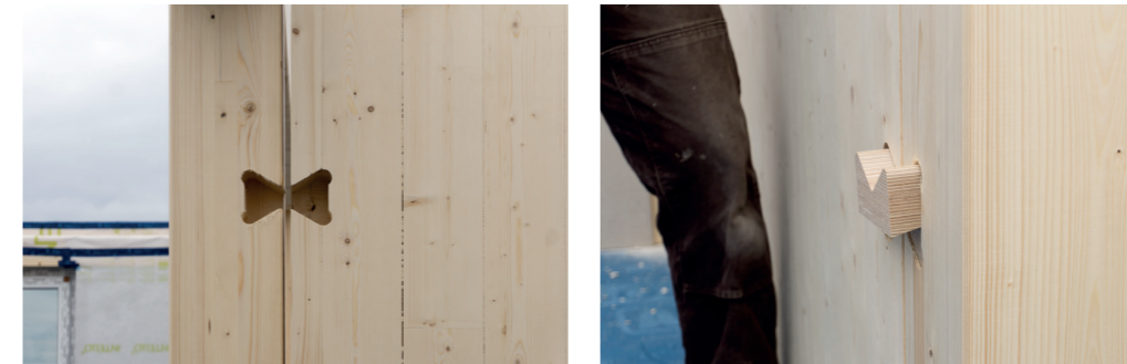
Abbildung 72: Montageprozess aussteifende Innenwände beim Modellvorhaben Fotos: DGJ Architektur.
