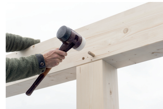
Abbildung 69: Montageprozess Unterzüge beim Modellvorhaben Fotos: DGJ Architektur.
