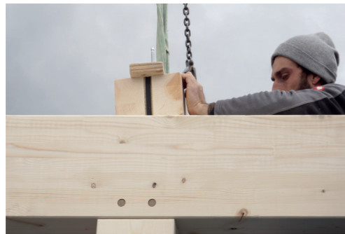
Abbildung 75: Montageprozess Deckenträger beim Modellvorhaben Fotos: DGJ Architektur.
