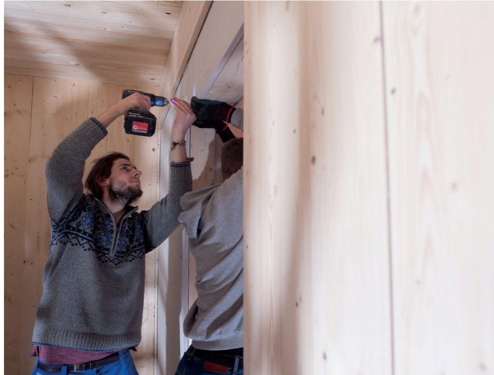
Abbildung 35: Montage der Beplankung an Ständerwänden. Foto: Carina Bauer.
