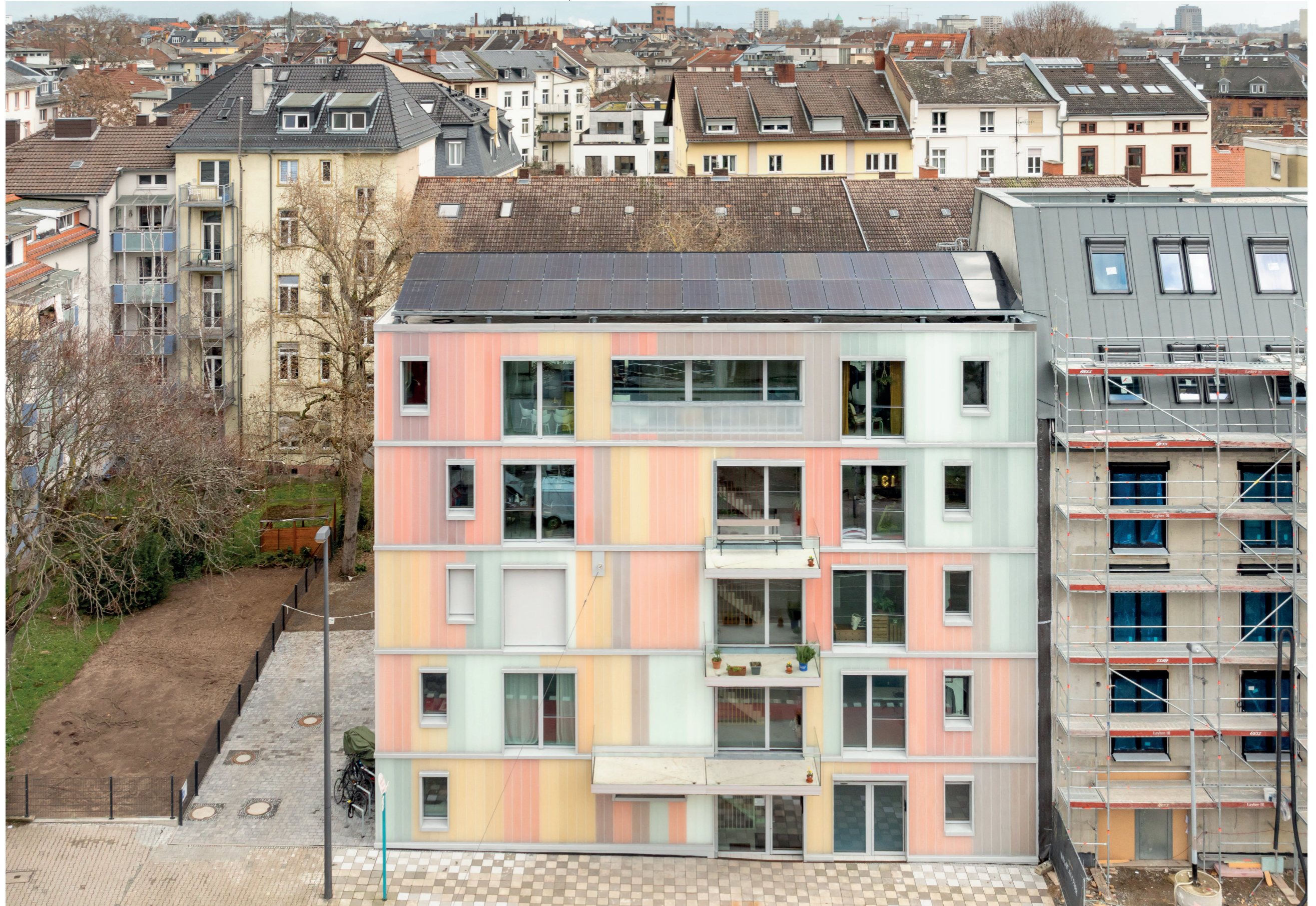
Abbildung 105: dgj228 Wohngruppe 'Gemeinsam Suffizient Leben', westliche Fassade zur Friedberger Landstraße hin. Dachansicht mit PV-Anlage. Das Gebäude erreicht KfW-Programm 153- sowie Frankfurt-Aktivhaus- Standard, besitzt außerdem eine hochdämmende Gebäudehülle, und, neben der hinterlüftete Fassade, eine Luft-Wärme-Pumpe.
