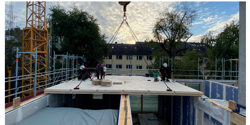
Abbildung 113: Montage der Decken, dgj228.
