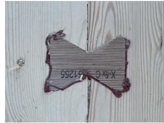
Abbildung 111: X-Fix Verbinder, Fugen ausgestopft mit Mineralwolle.
