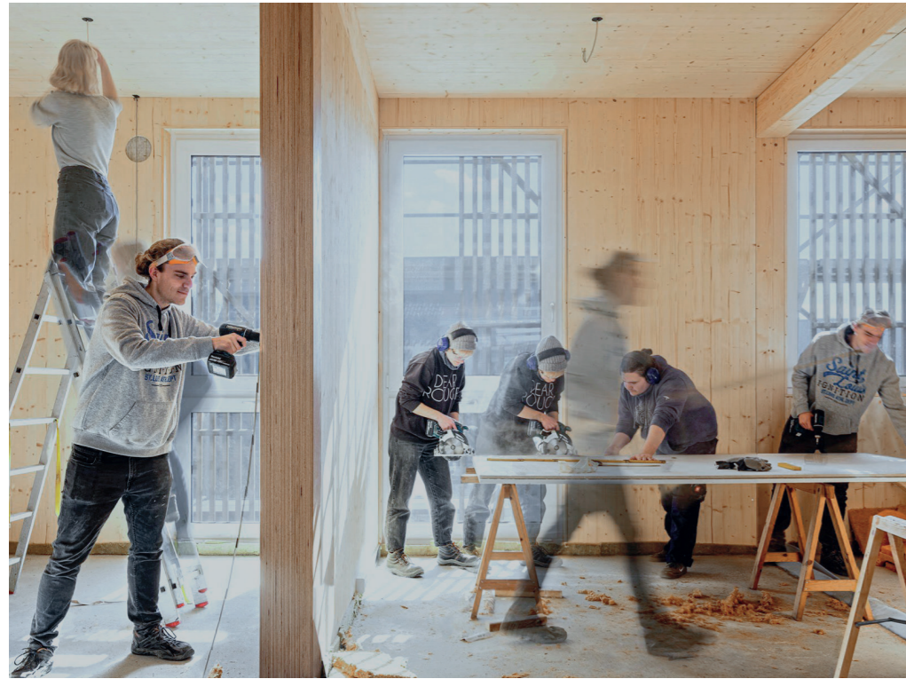
Abbildung 95: Montage der Trenn- und Innenwände im Selbstbau. Foto: Sabine Arndt.
