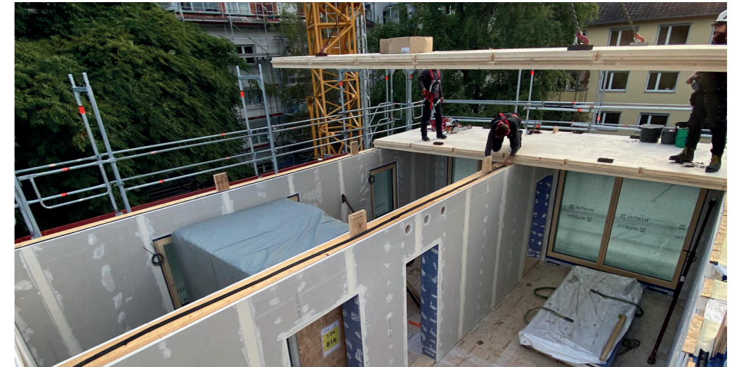
Abbildung 112: Montage der Decken, dgj228.
