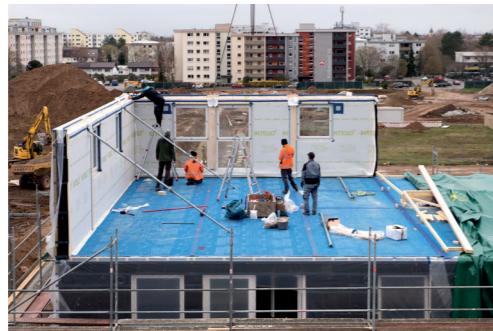
Abbildung 48: Aufstellung Außenwand 2.
