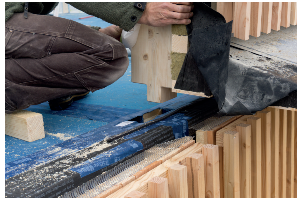
Abbildung 61: Fügung der Fassadenteile.
