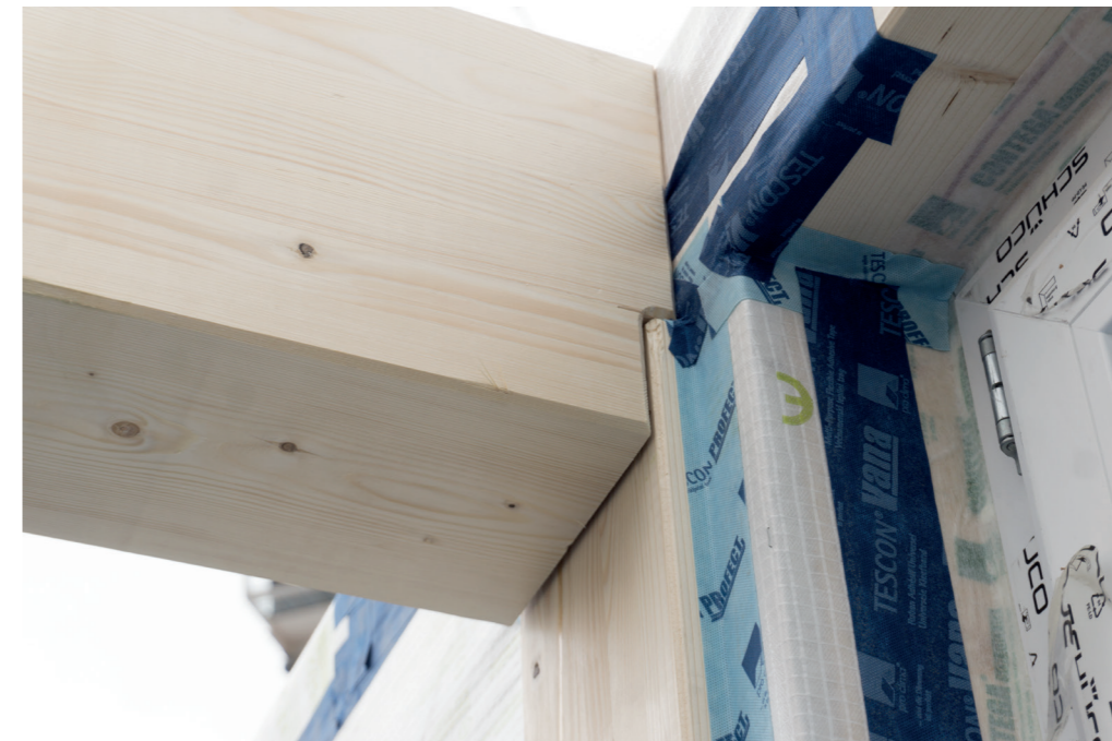
Abbildung 78: Montageprozess Deckenträger beim Modellvorhaben Fotos: DGJ Architektur.
