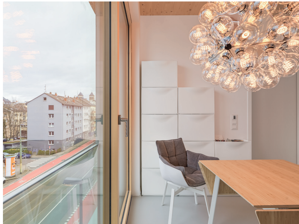
Abbildung 107: Die Friedberger Landstraße gehört zu den Hauptverkehrsadern von Frankfurt am Main. Entsprechend hoch waren die Ansprüche an den Schallschutz. Die Fassade ist eine einschalige Fensterkonstruktion, die sowohl den Wärme- als auch den Schallschutzanforderungen entspricht und die im Holzbau anspruchsvollen Einbaudetails zur Verhinderung der Flankenschallübertragung technisch umsetzt. Der Einsatz der Profilgläser als schallentkoppelte Schicht vor der vergleichsweise leichten Holz-Außenwand verbessert den Schallschutz wesentlich. Foto: Urheberrecht Thilo Ross Urh. Nr. 4026999, Quelle: DGJ Architektur GmbH.
