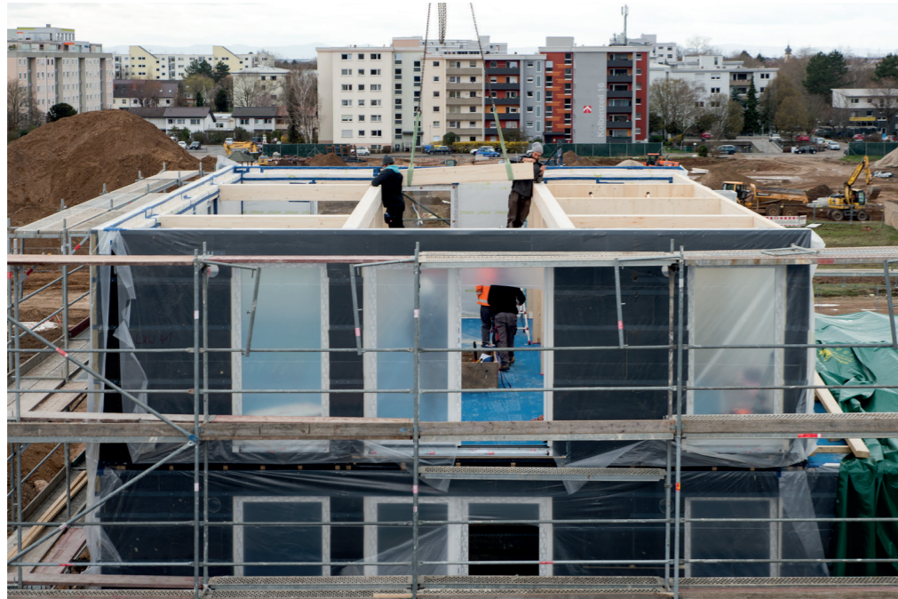
Abbildung 74: Montageprozess Deckenträger beim Modellvorhaben Fotos: DGJ Architektur.
