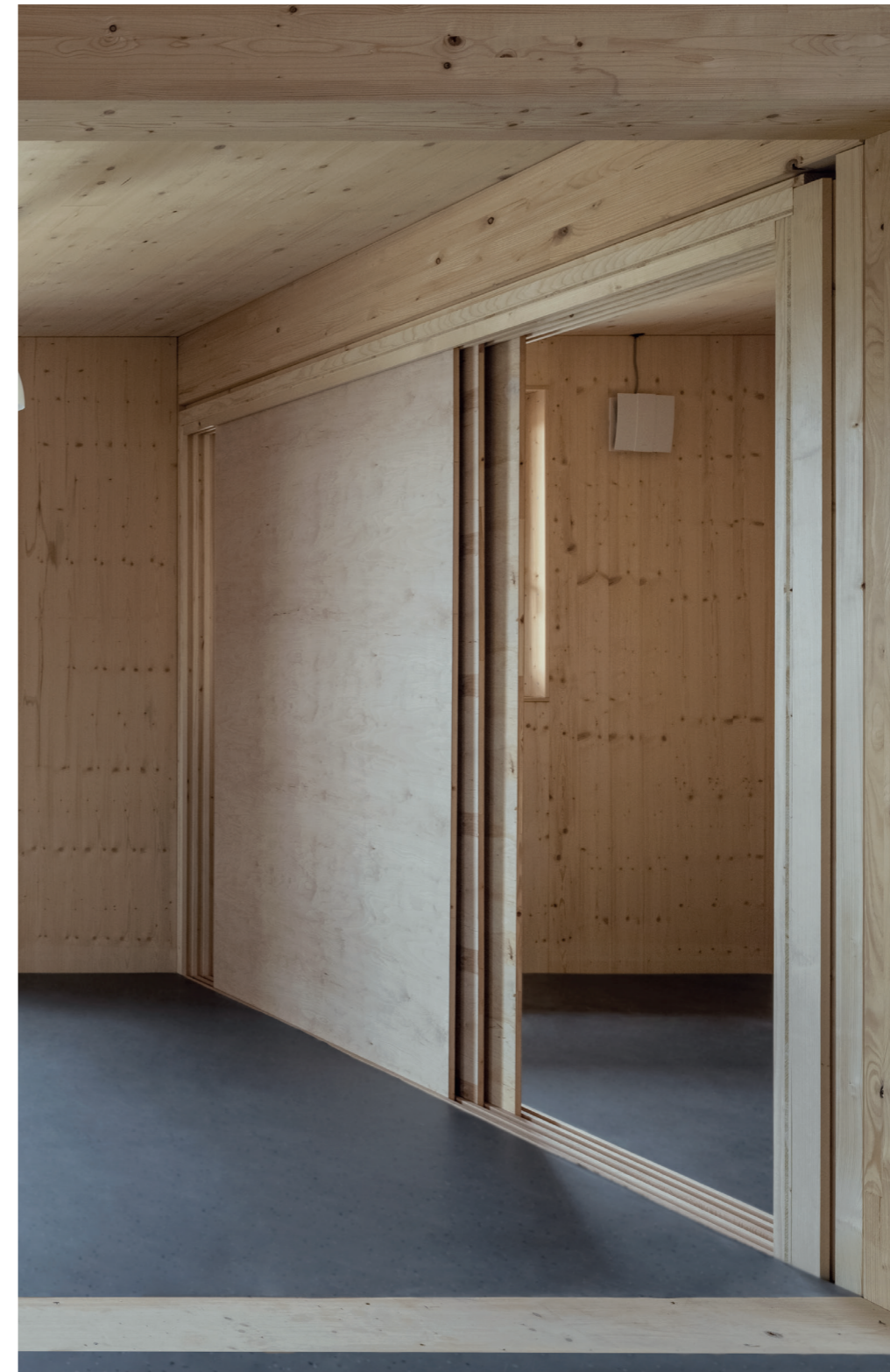
Abbildung 22: Schiebewände als Trennwand in der Wohnung beim Modellvorhaben des Studierendenwohnheims Collegium Academicum. Foto: Thilo Ross.
