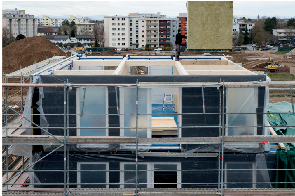
Abbildung 79: Montageprozess Nasszellen beim Modellvorhaben Fotos: DGJ Architektur.
