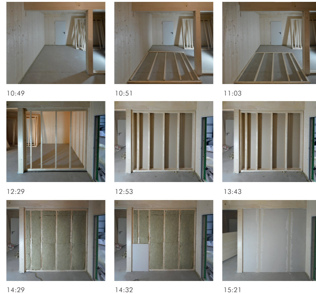
Abbildung 34: Aufbauschritte zweischalige Ständerwand TW05. Fotos: DGJ Architektur, 04.04.2019.
