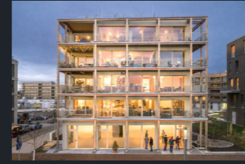
dgj253 WohnWerk Mannheim Wohngruppe mit gemeinschaftlicher Nutzung 4 Mio. Euro | WohnWerk eG | LP 1–7 | 2019 bis 2023
