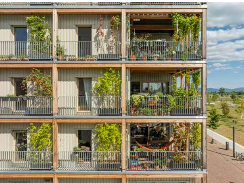
Da die Gestaltungsrichtlinie keine vorhängten Balkone zum BUGA-Gelände erlaubte, schuf DGJ Architektur mit der begehbaren Grünfassade gleichzeitig Loggiabalkone für die Bewohnerinnen
