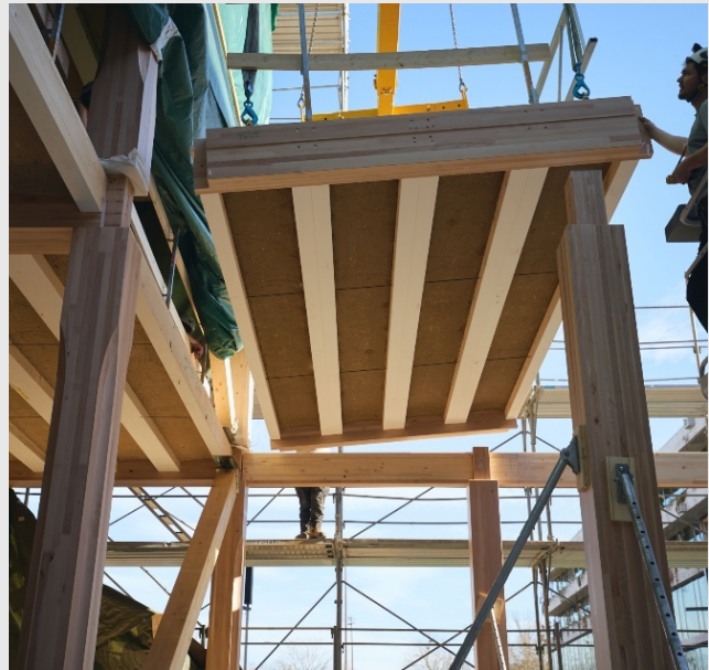
Bild der Vorfertigung vor Ort (links), Montage eines Deckenfeldes (rechts) ©Senn, David Walter 30
