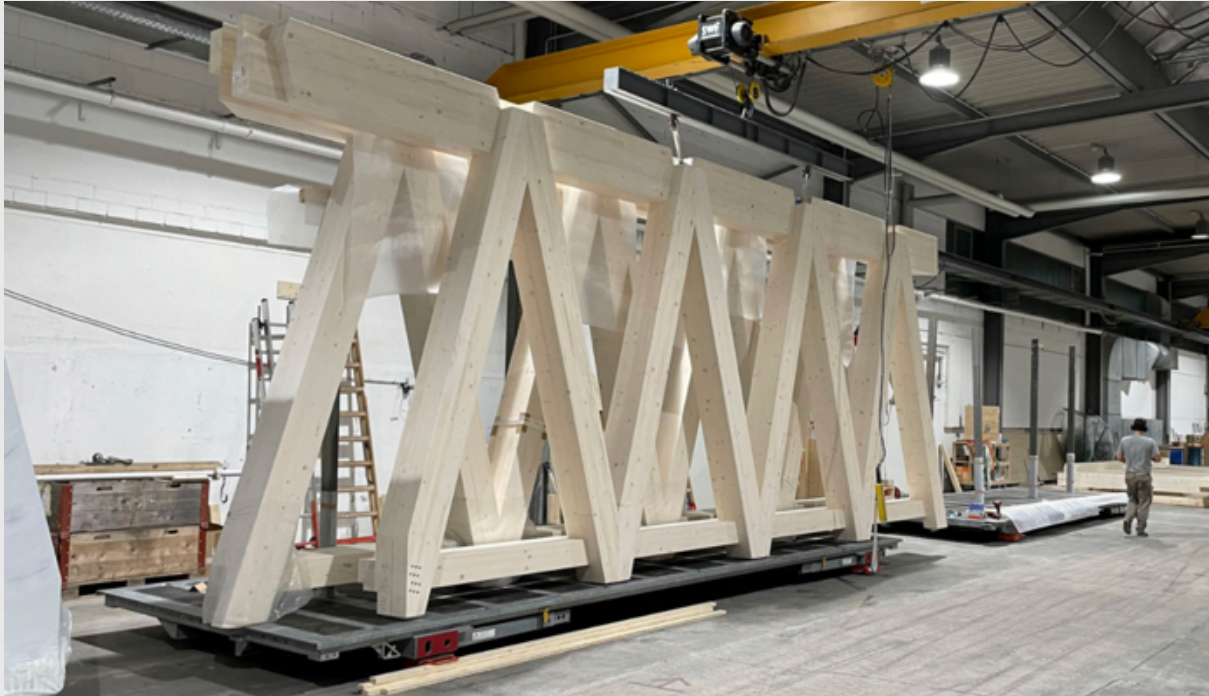
Bild der vorgefertigten Tragwerkselemente der Fassade 34
