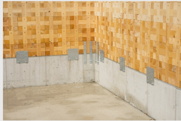
Foto des Triqbriq-Systems inklusive der Verriegelung mittels Buchenholzdübel (links) ©Lars Krumpfuss, Foto einer fertigen Wandecke inklusive Zugankern und Schublechen (rechts) ©Lars Krumpfuss
