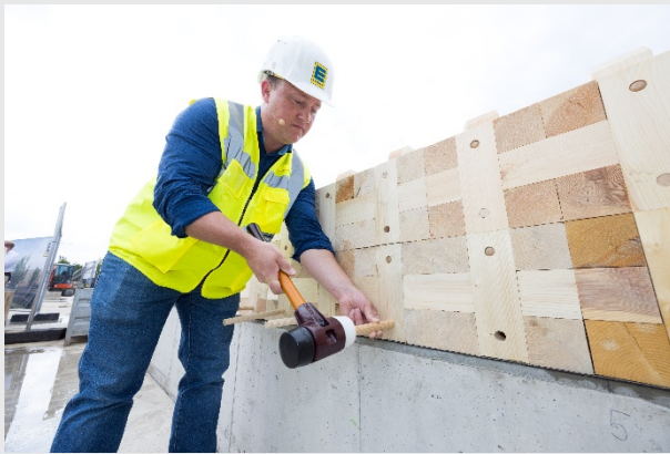
Foto des Triqbriq-Systems inklusive der Verriegelung mittels Buchenholzdübel (links) ©Lars Krumpfuss, Foto einer fertigen Wandecke inklusive Zugankern und Schublechen (rechts) ©Lars Krumpfuss
