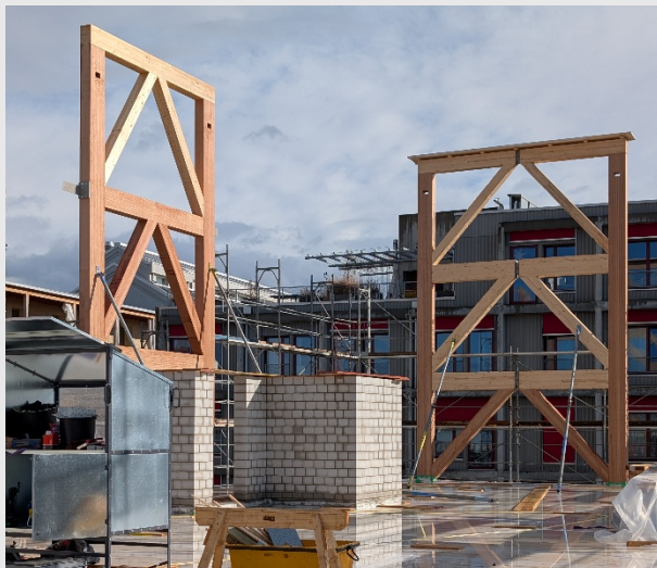
Bild der K-Verbände während nach der Montage (links) ©Alexander Gebetsroither, Darstellung des Tragwerks inkl. K-Verband und Bretterfachwerk (rechts)
