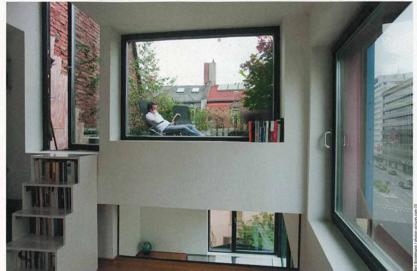
Hitzestau vermieden: Dreifach verglaste Fenster lassen viel Sonne herein, die im Winter beim Beheizen der Räume hilft. Jalousien verhindern sommerliche Überhitzung.
