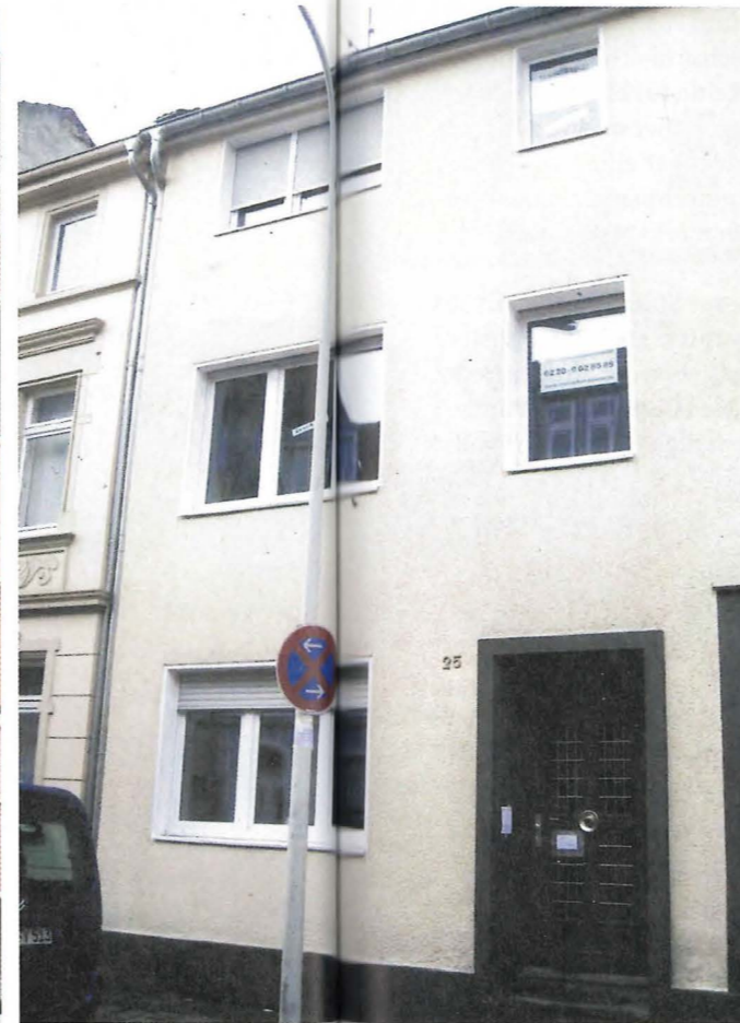
Die Straßenansicht erhielt ein neues Gesicht. Fenster wurden verlegt und die ehemalige Durchfahrt verglast.
