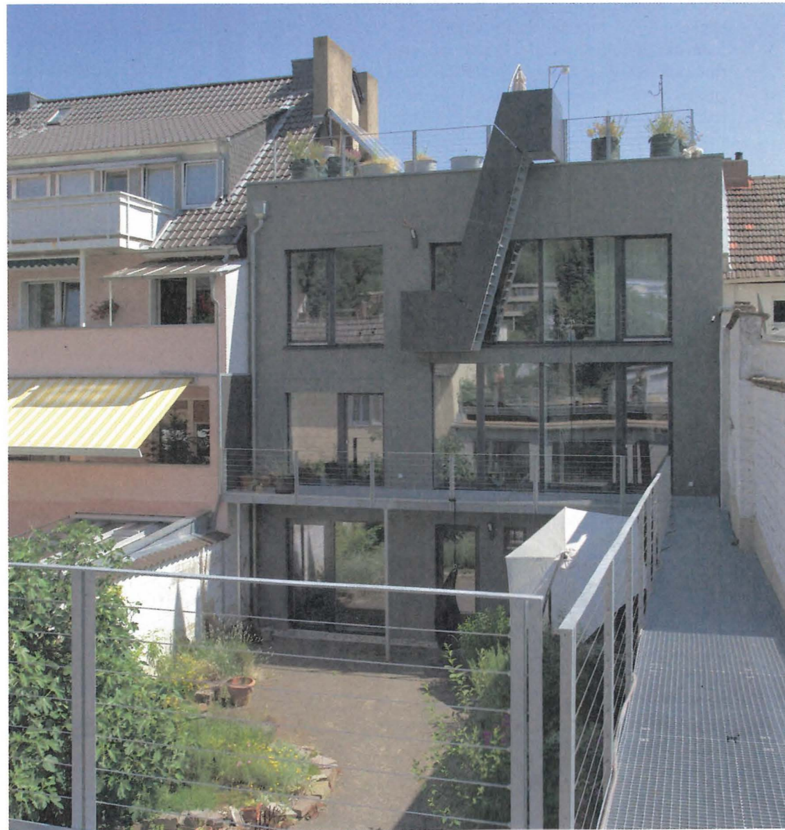
Ein Gittersteg verbindet das Vorderhaus mit der Dachterrasse auf der ehemaligen Druckerei. Den Freisitz auf dem Hauptgebäude erschließt eine markante Außentreppe.
