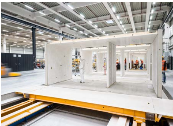
Abb. 16: Produktionsschritte in der Vorfertigung: Herstellung der Fertigteile, Montage, Innenausbau (Quelle: Max Bögl Modul)
